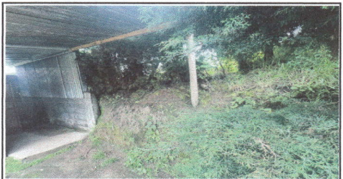
Foto 6: Sustitucion de muro perimetral de block 20 M2
